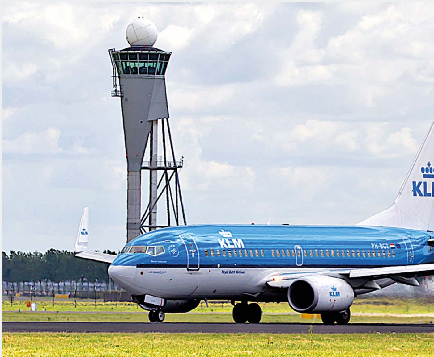
Die Amsterdamer „Polderbaan“ hat ihren eigenen Tower. Foto: LVNL
